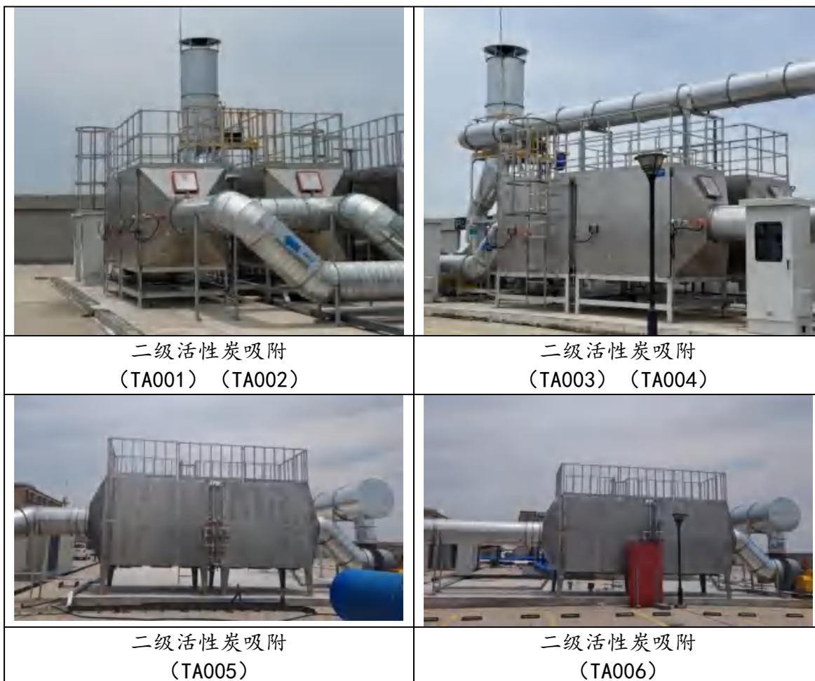
图4-2焊接、点胶、清洁废气治理设施照片
