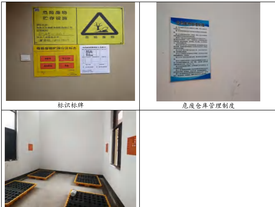
图 4-3 危险废物暂存间照片
